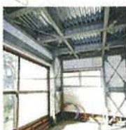
フレーム工事
